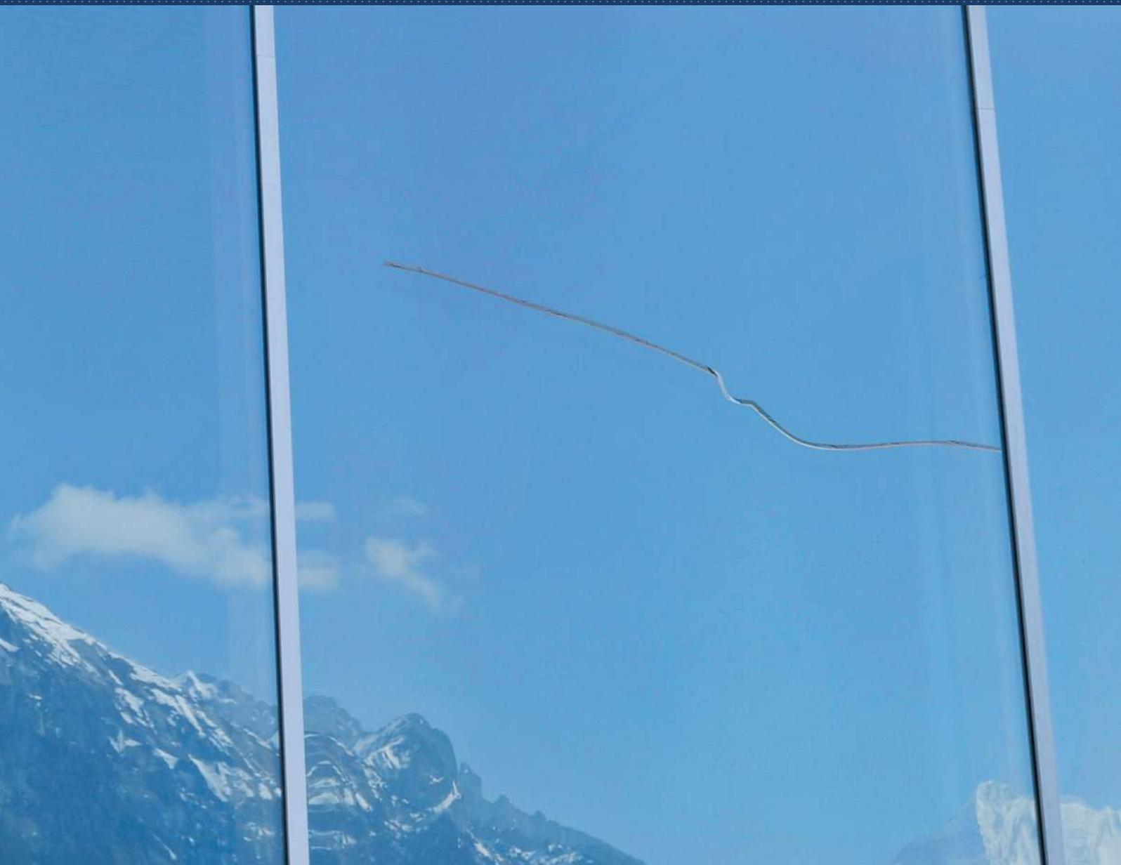
Glas ist ein Werkstoff, der unterschiedlichsten Belastungen standhält. Werden jedoch nicht alle Beanspruchungen berücksichtigt oder durch die Nutzung ungewollte Belastungen eingebracht, kann es zu einer Überschreitung der Belastungsgrenze führen. Das Glas bricht spontan. Dabei können Überlagerungen verschiedener Einflüsse die Belastungsgrenze des Glases reduzieren. Temperaturunterschiede im Glas selbst sind von besonderer Bedeutung und müssen zusätzlich berücksichtigt werden.
